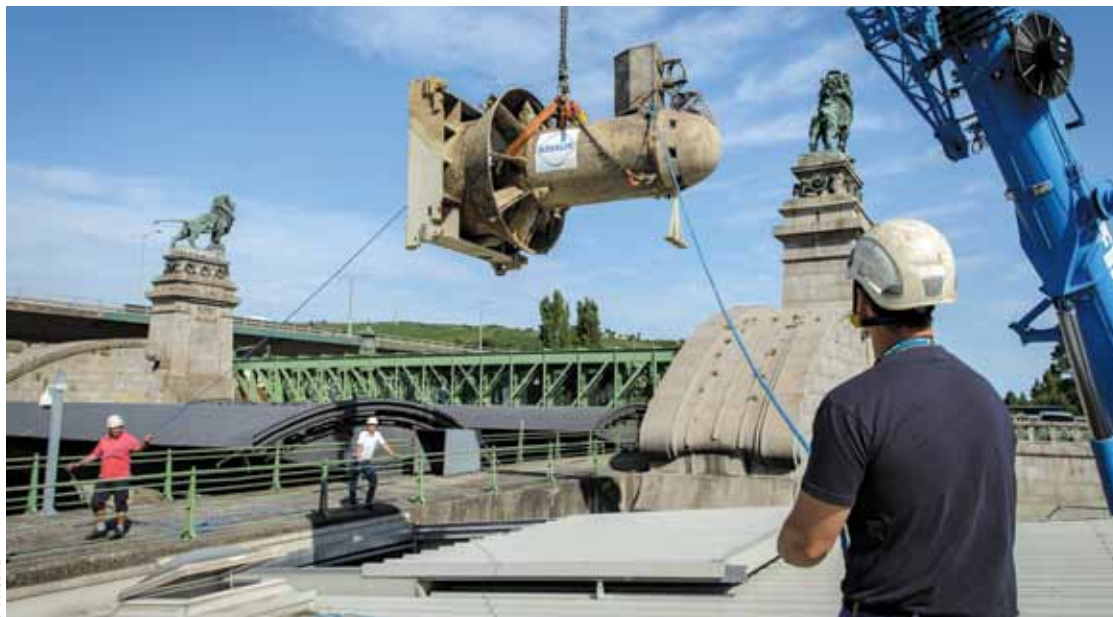
Aushub der Forschungsturbine StreamDiver nach fünf Jahren Probebetrieb im Verbund-Kraftwerk Nußdorf/Donaukanal.
