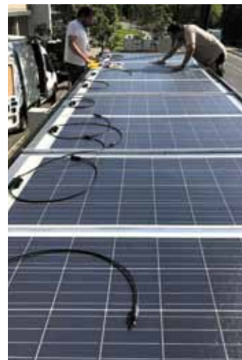
Die flexiblen Solarmodule auf dem Dach sorgen für die notwendige Stromversorgung.
