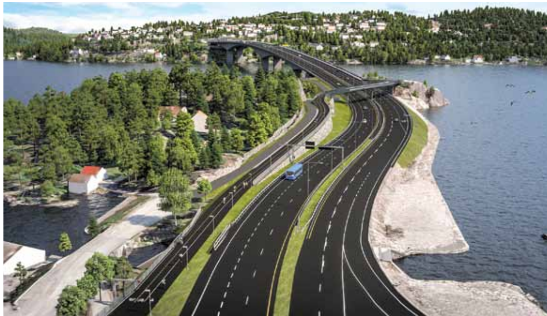
Porr baut eine rund 654 m lange Brücke (Bild: Modellansicht) mit sechs Fahrspuren inkl. Fuß- und Radweg.
